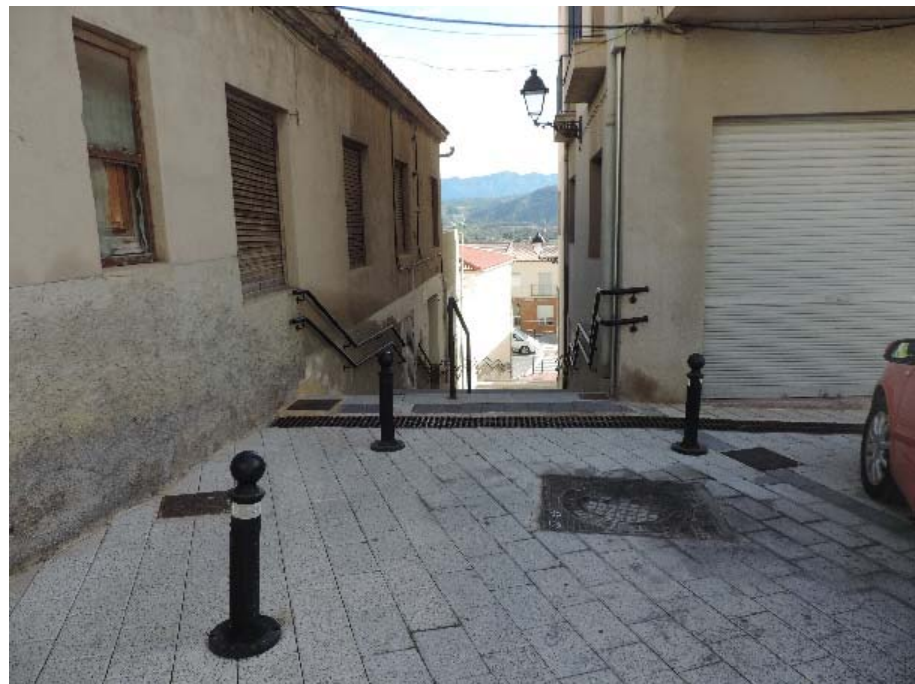
IMAGEN 6.7-d: OBSTÁCULOS QUE LIMITAN UNA ADECUADA ACCESIBILIDAD DESDE LA CALLE A LAS ESCALERAS.
