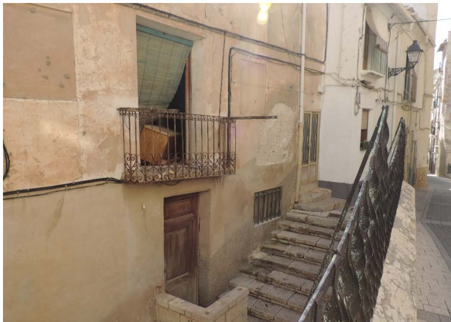
IMAGEN 5.4.4 b.- EJEMPLO DE EDIFICIO DONDE RESULTA COMPLEJA LA MEJORA DE LAS CONDICIONES DE ACCESIBILIDAD A LAS VIVIENDAS.
