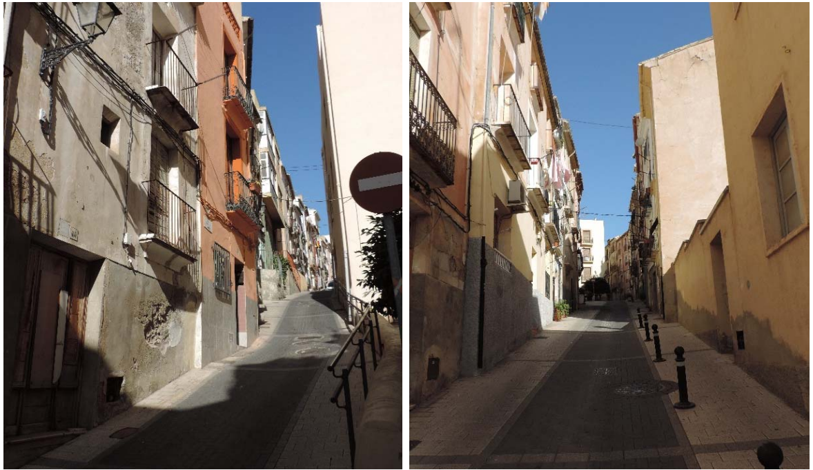
IMAGEN 6.7-b: PENDIENTES LONGITUDINALES DE CALLES EXCESIVAS
