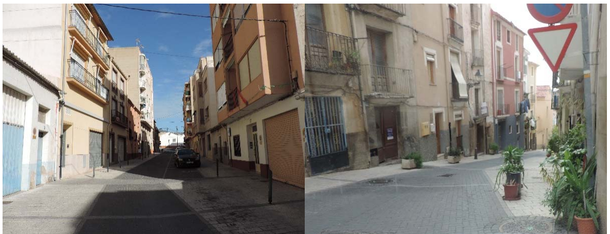
IMAGEN 6.7-c: PENDIENTES LONGITUDINALES DE CALLES EXCESIVAS Y JARDINERAS QUE OCUPAN ZONAS PEATONALES Y QUE GENERAN OBSTÁCULOS A LOS VIANDANTES.
