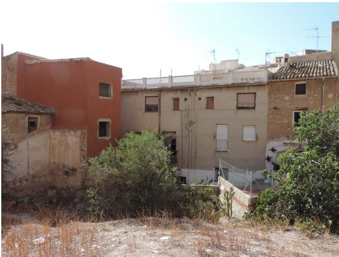
IMAGEN 5.2.1-c: VISTA DE LA ZONA AFECTADA POR LA UA nº 8
