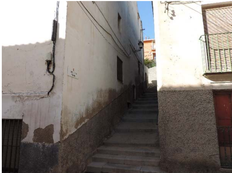
IMAGEN 6.7-f: PENDIENTES LONGITUDINALES EN ESCALONES. TRAMOS DE PENDIENTES SIN BARANDILLAS
