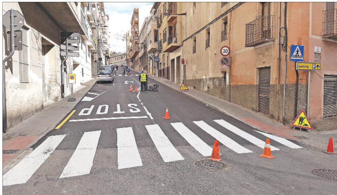
Treballs que es van fer a finals de l'any passat per millorar el carrer Marcel Mira.
