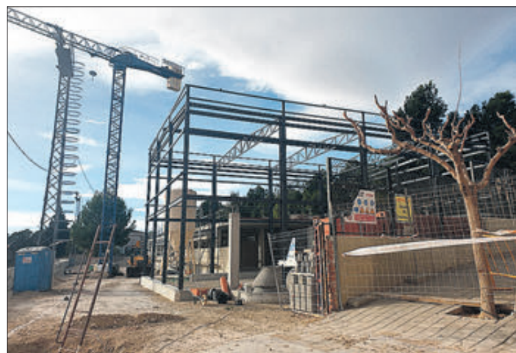
S'està construint el nou edifici en el centre Sagrada Família. TERE CARBONELL
