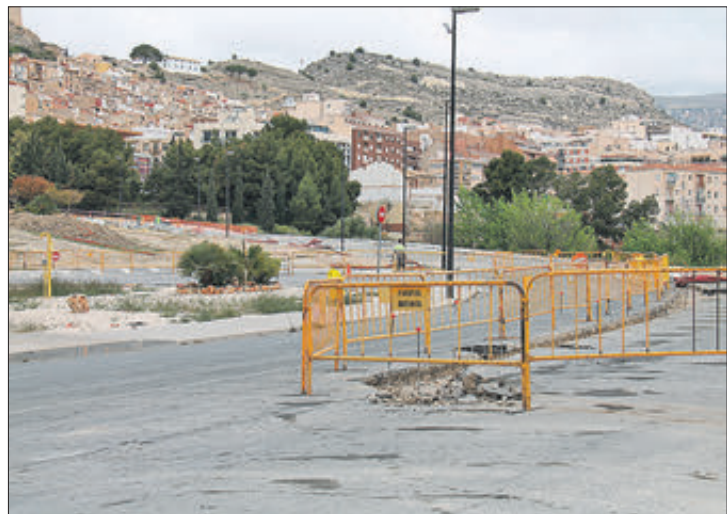
Imatge de hace algunas semanas de las obras.
