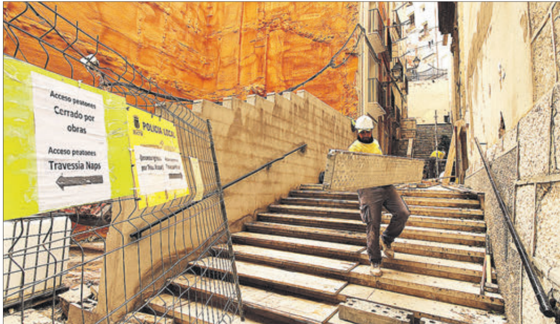
Els treballs de demolició ja estan en marxa.
