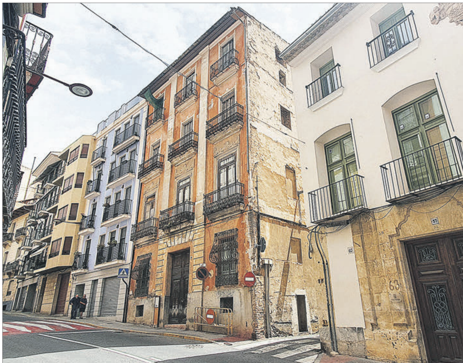
En el centre la Casa Aracil, al costat de la Casa Rovira que ja ha sigut rehabilitada.
