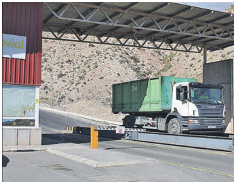
Accessos a l'abocador de Pedra Negra.
