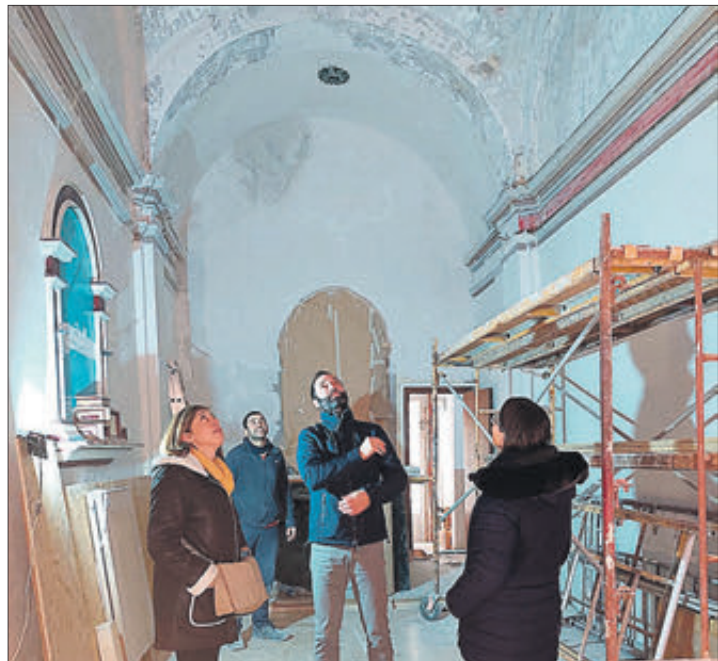
Visita a las obras.
