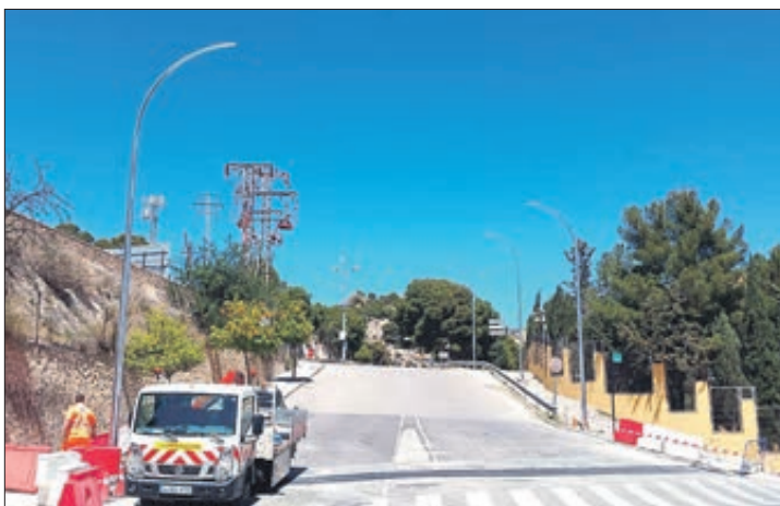
Instal·lació dels fanals.
