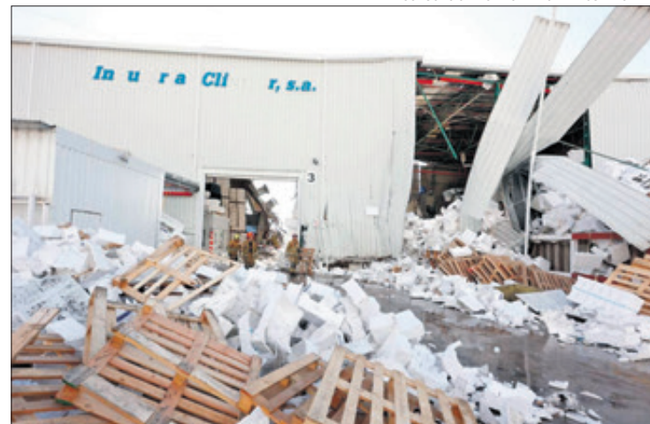
Estado en el que quedó la nave tras la explosión.
