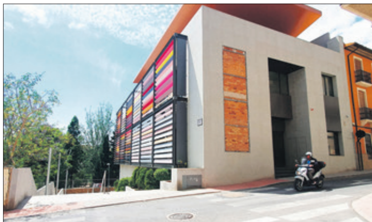
Instal·lacions del futur Centre de Dia.
